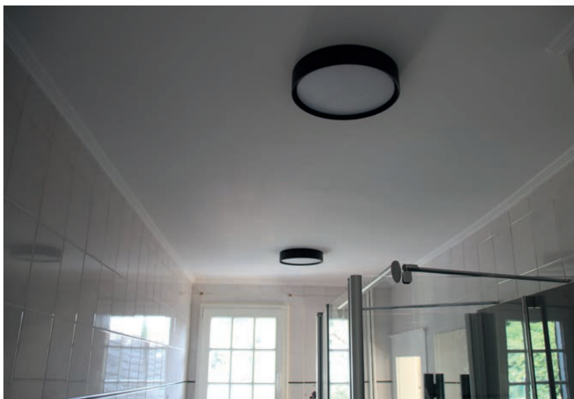
Decke Bad nachher
